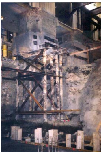
Untergeschoss auf Mikropfählen
