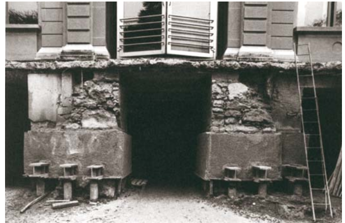
Ausbau des Untergeschosses
